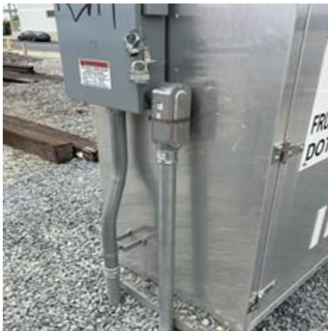
Carcasa de los cables reparada.
