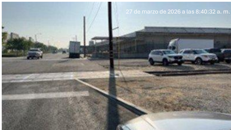
Falta de señalización en el acceso en dirección este
